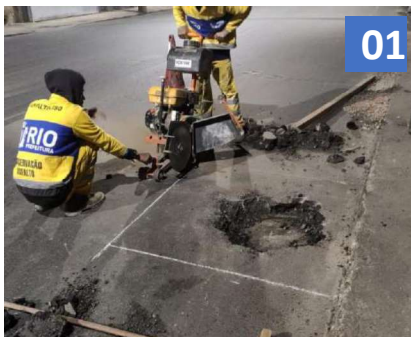
01 – MARCAÇÃO E CORTE NA GEOMETRIA DEFINIDA EM PROJETO
