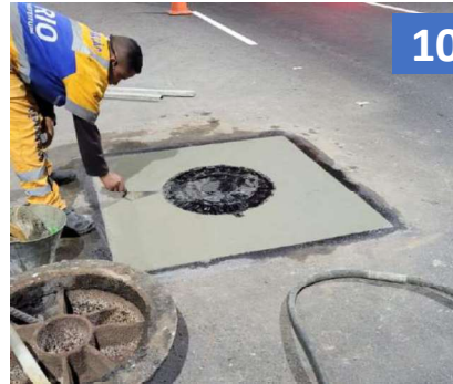
10 – ACABAMENTO DA SUPERFÍCIE DO CONCRETO EVITANDO-SE O MÍNIMO DE IRREGULARIDADES
