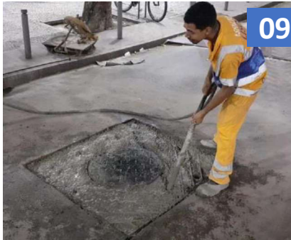
09 – ADENSAMENTO DO CONCRETO COM VIBRADOR
