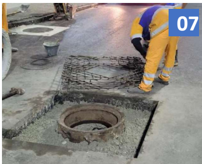
07 – POSICIONAMENTO DA ARMADURA DE AÇO
