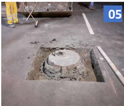
05 – REASSENTAMENTO DO TAMPÃO E NIVELAMENTO
